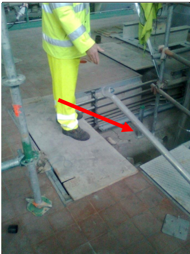
Obrázok 8 V strojovni sú otvory, ktoré nie sú zabezpečené proti pádu zamestnancov
