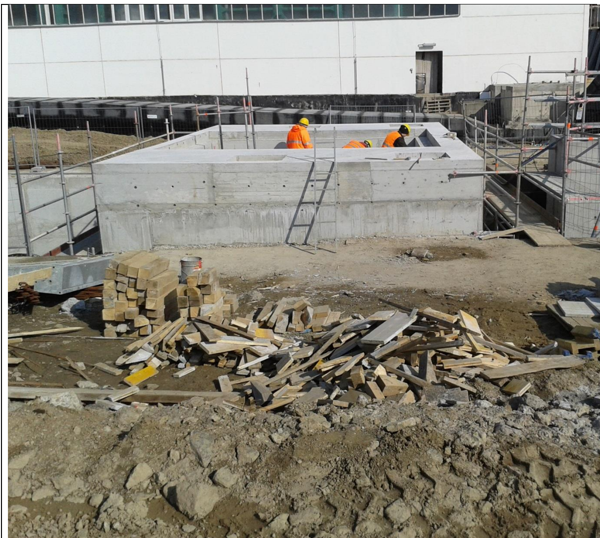
Obrázok 17 Viacero porušení: pracovisko nebolo označené, neboli riadne výstupy do šachty a von, vzdialenosti od okraja a lešenia je viac ako 25 cm, chýbali prvky na lešení, neporiadok , oplotenie nebolo riadne zabezpečené
