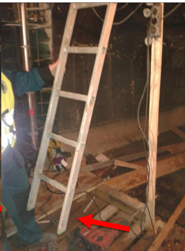
Obrázok 5 Lešenie ktoré nemalo riadne zabezpečený výstup - nezabezpečená stabilita
