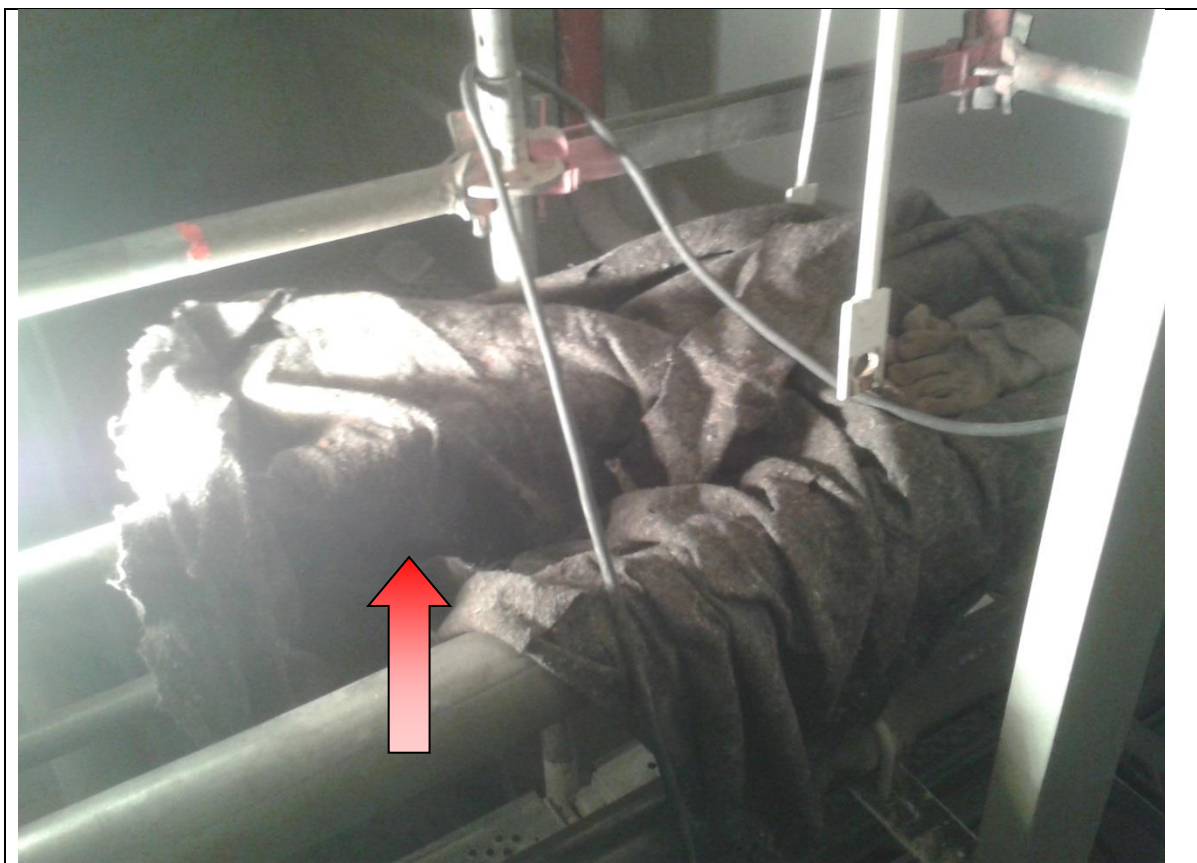
Obrázok 14 Na pracovisku sa vykonávali zvaračské práce a prechádzajúci zamestnanci neboli chránení proti odletujúcim iskrám a žiareniu
