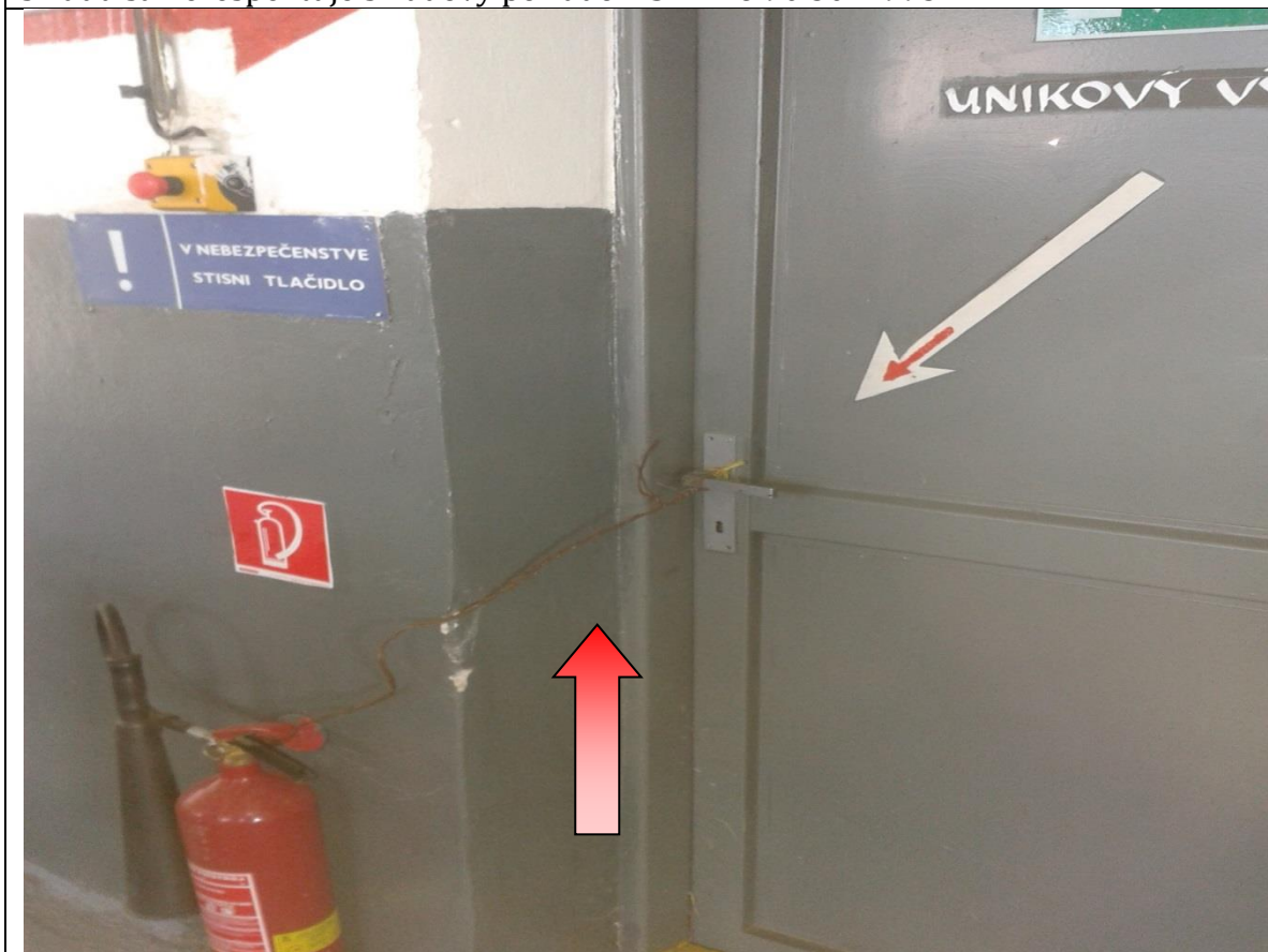
Obrázok 12 Dvere únikového východu neboli voľné, boli zaistené drôtom o hasiaci prístroj
