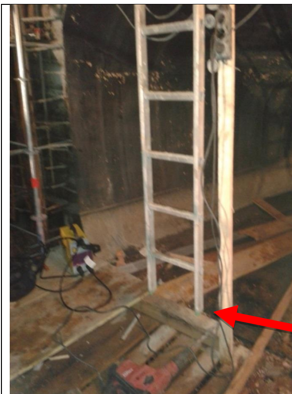
Obrázok 4 Lešenie, ktoré nemalo riadne zabezpečený výstup - nezabezpečená stabilita
