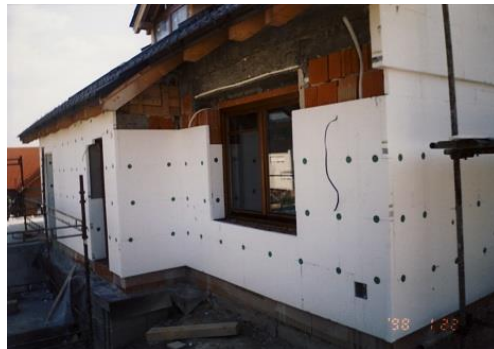
Obrázok 47 Využitie polystyrénu v praxi (zdroj, http://www.rekons.sk/zateplenie-polystyrenom-finalnou-fasadou )
