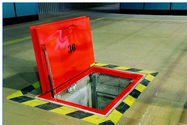
Obrázok č.3 a 4: Poklopy a kryty, ktoré bránia pádu osôb do hĺbky
